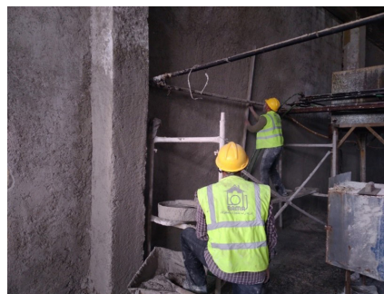
Herstel werkzaamheden na de aardbevingen
